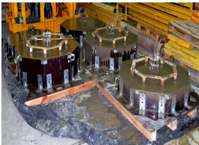
Rys. 3.24. Widok modeli serii trzeciej po zakończeniu betonowania płyt Fig. 3.24. View of third series after ending of concreting the plates
