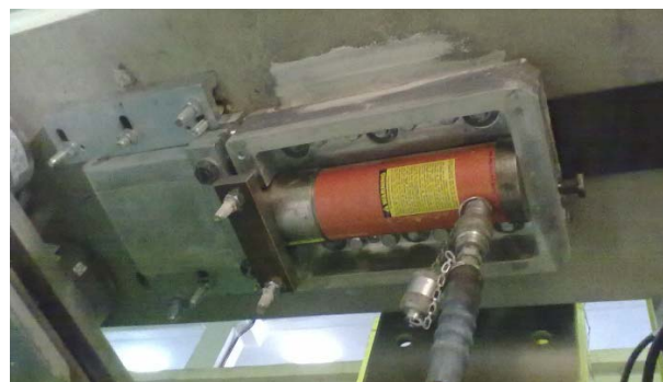
Rys. 2.9. System kotwiąco – sprężający zamontowany na wzmocnianym elemencie
