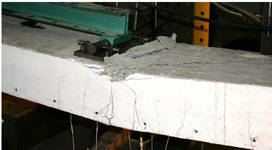
Rys. 3.3. Zniszczenie na skutek zmiżdżenia betonu w belce B12-sp Fig. 3.3. Concrete crushing in the B12-sp beam
