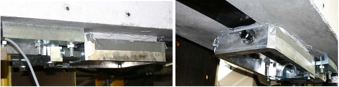
Rys. 2.18. Klej znajduje się wyłącznie w miejscu zakotwienia taśmy Fig. 2.18. The adhesive is applied only at the point of anchoring of the strip
