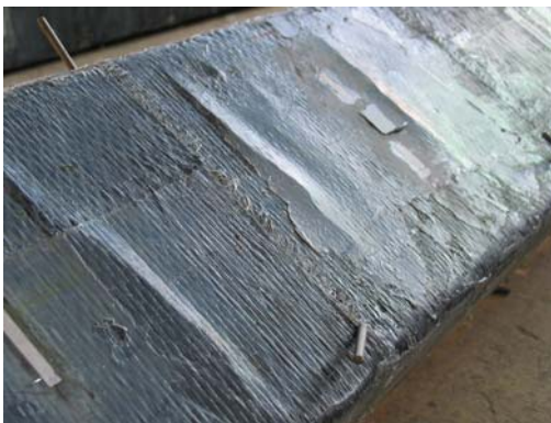
Rys. 3.19. Zmiążdżenie betonu w słupie S-t/2m (widoczne wybrzuszenia maty)
