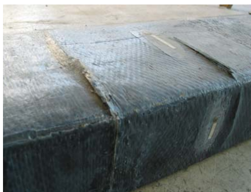
Rys. 3.20. Zmiążdżenie betonu w strefie ściskanej słupa S-m/2m (widoczne wybrzuszenia i zerwanie włókien maty)
