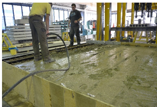
Rys. 2.7. Betonowanie belek Fig. 2.7. Casting of beams
