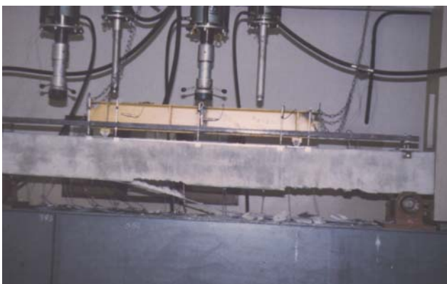
Rys. 4.3. Postęp zniszczenia belki B-08/S Fig. 4.3. The mode of failure of the beam B-08/S
