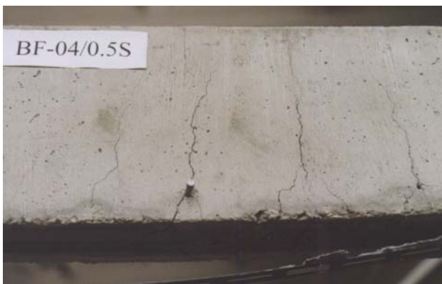
Rys. 4.4. Postęp zniszczenia belki BF-06/S Fig. 4.4. The mode of failure of the beam BF-06/S
