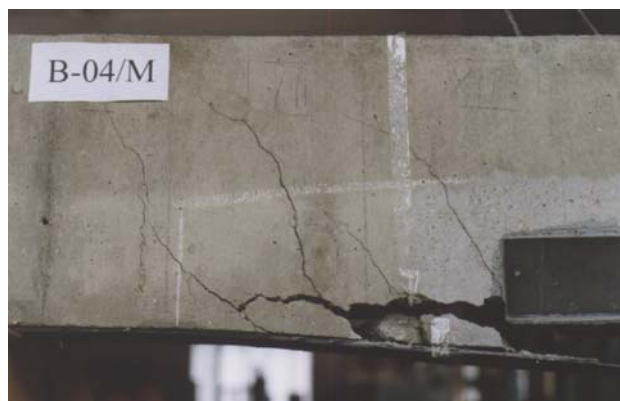
Rys. 4.2. Postęp zniszczenia belki B-04/M Fig. 4.2. The mode of failure of the beam B-04/M
