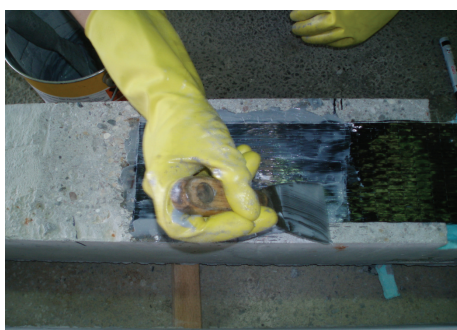
Rys. 3.10. Sposób aplikacji materiałów CFRP: a) przyklejanie mat, b) wklejanie taśm w bruzdy betonowej otuliny Fig. 3.10. Mode of application of CFRP materials a) externally bonded sheets, b) NSM strips
