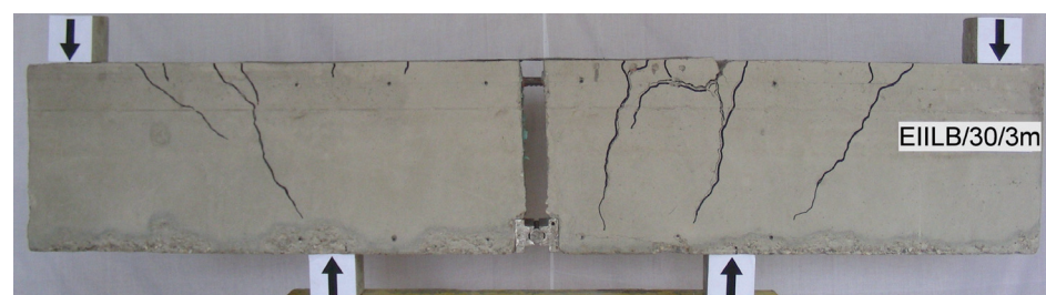
Rys. 5.26. Układ rys w belce EIILB/30/3m, wzmocnionej zewnętrznymi matami Fig. 5.26. Cracking pattern in beam EIILB/30/3m externally strengthened with sheets
