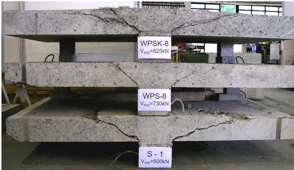
Rys. 3.8. Modele pierwszej serii w przekroju poprzecznym po zniszczeniu Fig. 3.8. First series models in the cross-section after failure
