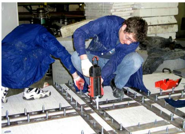
Rys. 3.2. Wklejanie śrub mocujących płaskowniki Fig. 3.2. Insertion the bolts fixing the flat irons
