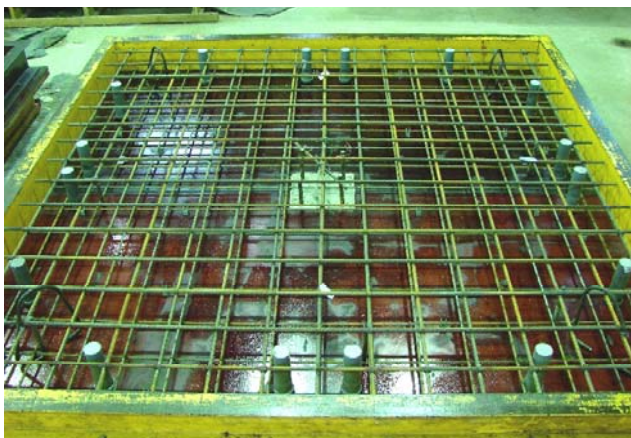
Rys. 2.2. Zbrojenie płyty
