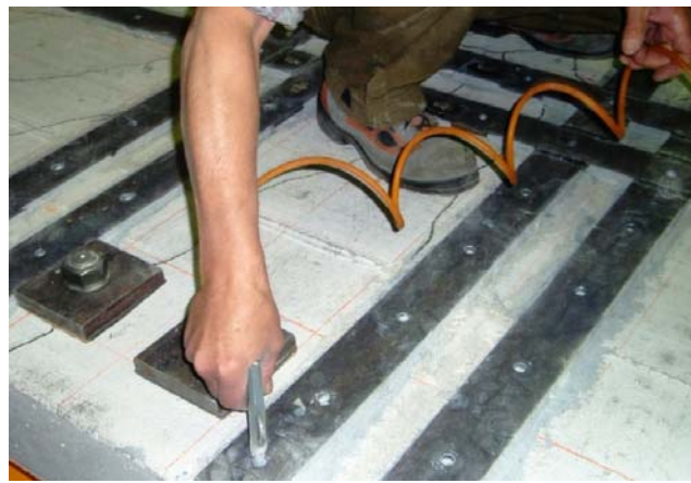
Rys. 5.4. Czyszczenie otworów pod śruby sprężonym powietrzem Fig. 5.4. Cleaning the opening under the bolts with the compression air
